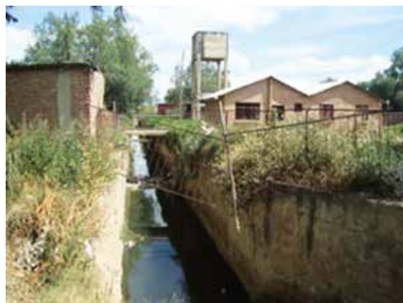
Fotografía 1. Muros de canal como parte de la infraestructura privada
