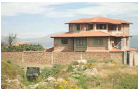
Fotografía 4. El cauce de la torrentera atraviesa por una sección estrecha por debajo de la vivienda.
