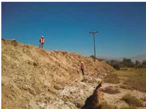
Fotografía 8. Levantamiento Topográfico de taludes y áreas de inundación (río Rocha).
