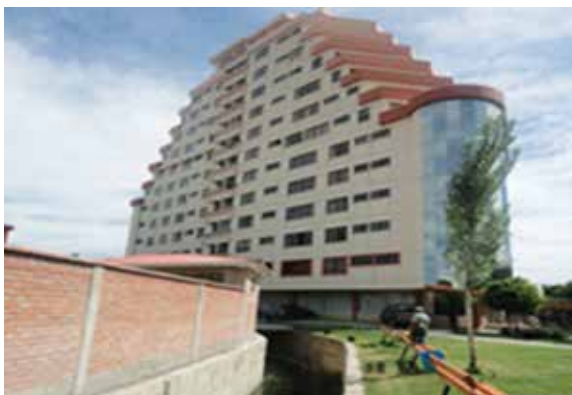
Fotografía 3. Muros de canal como parte de la infraestructura privada.
